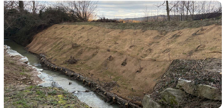
Travaux à Grange Basse
